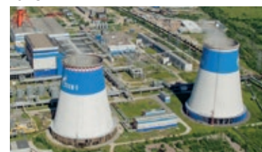
Реконструкция сетей канализа- ции на Правобережной ТЭЦ-5 Санкт-Петербург, 2018
